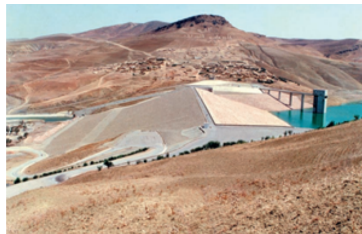
Photo 1 . Le barrage Sidi Chahed
