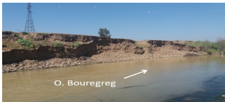
Photo 1 . Berge fortement sapée en rive gauche du Bouregreg à proximité de douar d'Ait Amghar à Maaziz (26/08/2017).
