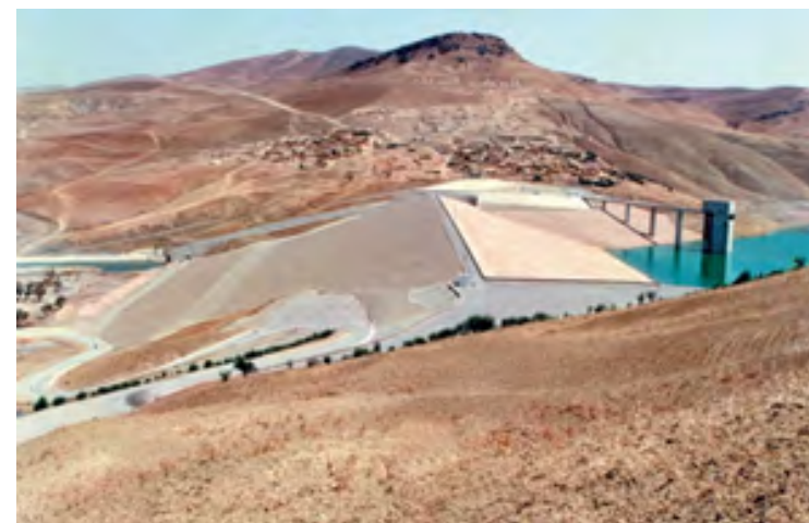
Photo 1 . Le barrage Sidi Chahed
